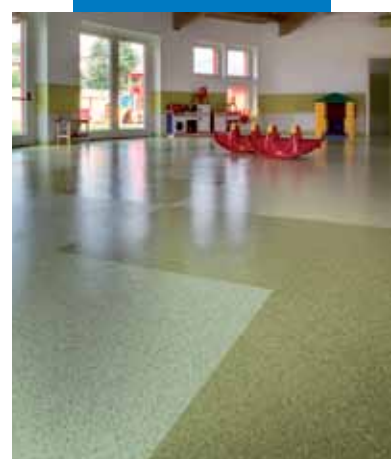
Ukázka pokládky pryžové krytiny ve škole: Municipal Infants School, Carobbio degli Angeli (Bergamo)
