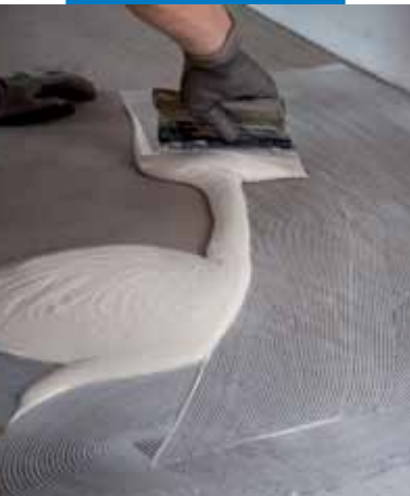
Nanášení Ultrabondu Eco V4 SP Fiber na podklad
