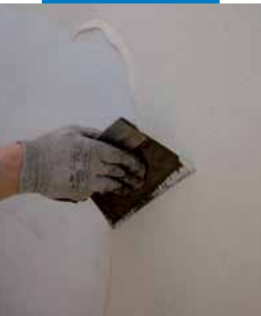
Nanášení Ultrabondu Eco V4 SP Fiber na stěnu
